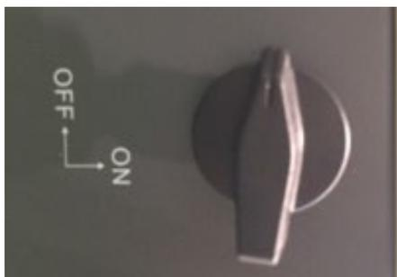
Figura 67 - Sezionatore fotovoltaico
