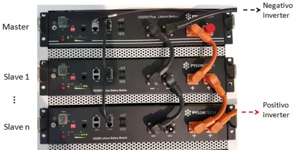
Figura 20 – Parallelo di tre batterie Pylontech
