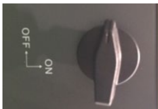
Figura 70 - Interruttore di disconnessione fotovoltaico
