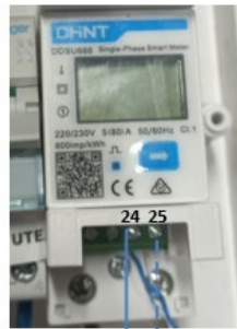
Abbildung 29 – PIN-Anschlüsse ZSM-METER-DDSU-Messgerät
