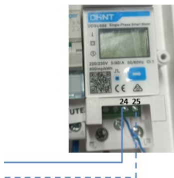
Rysunek 29 - Połączenia PIN miernika ZSM-METER-DDSU
