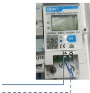
Rysunek 29 – Podłączenie pinów miernika ZSM-METER-DDSU
