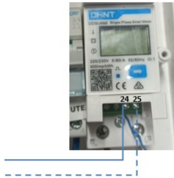
Рисунок 29 - Підключення контактів лічильника ZSM-METER-DDSU
