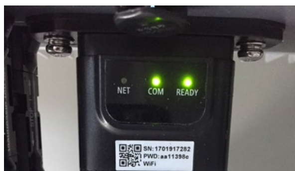
Figura 113 – Estado inicial de los led
