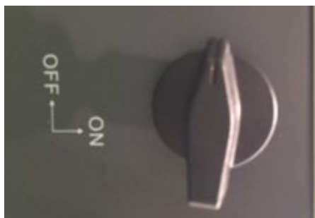
Figura 74 - Seccionador fotovoltaico
