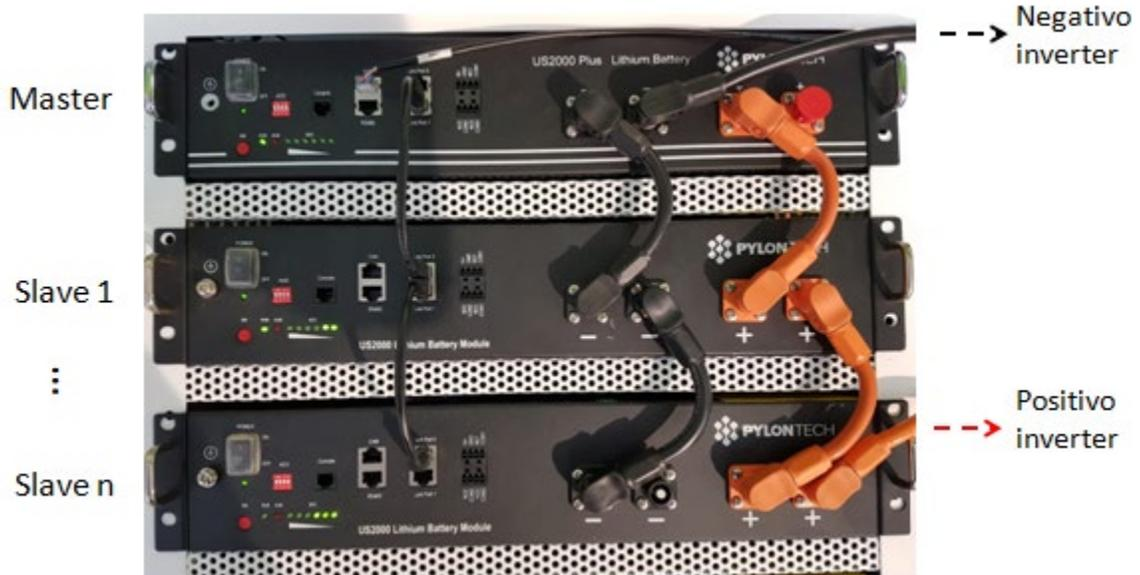
Figura 10 - Paralelo de tres baterías Pylontech
