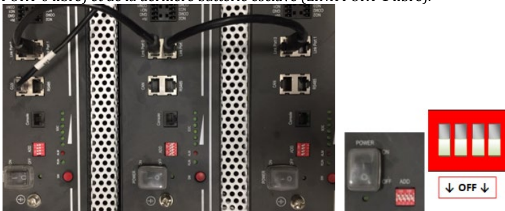
Figure 14 - Connexion du câble de communication entre trois batteries Pylontech
