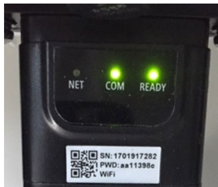
Figure 140 – État de communication irrégulière entre carte et serveur à distance
