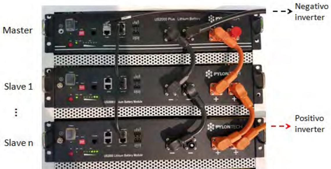
Figure 17 – Connexion de trois batteries Pylontech en parallèle
