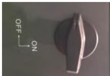
Figure 109 – Sectionneur photovoltaïque
