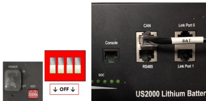
Рисунок 12 – Підключення комунікаційного кабелю до акумуляторної батареї Pylontech
