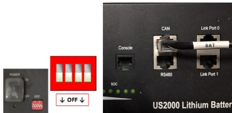
Рисунок 17 – Підключення комунікаційного кабелю до акумуляторної батареї Pylontech
