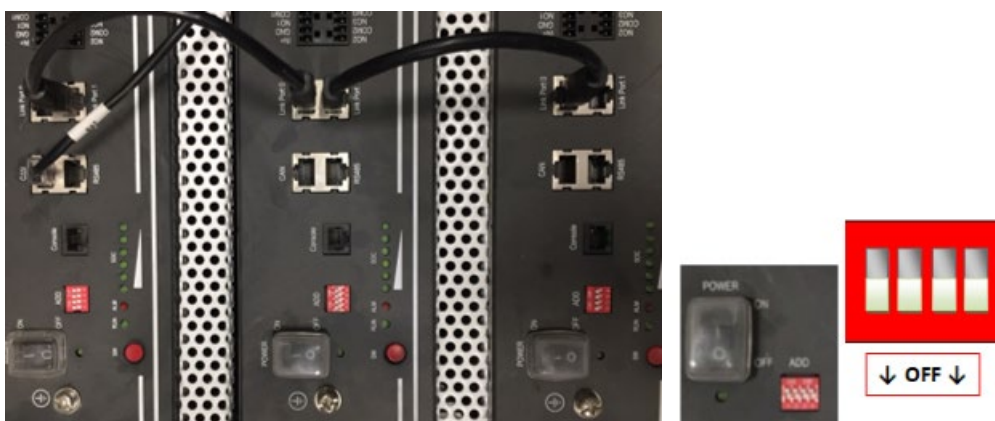
Рисунок 14 – Підключення кабелю між трьома акумуляторами Pylontech
