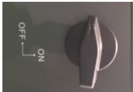
Рисунок 99 – Роз'єднувач фотоелектричних модулів
