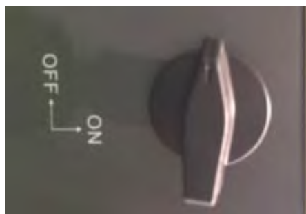
Рисунок 111 – Роз'єднувач фотоелектричних модулів
