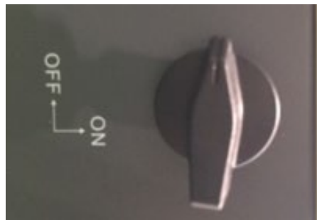
Рис.67 - Фотоелектричний роз'єднувач
