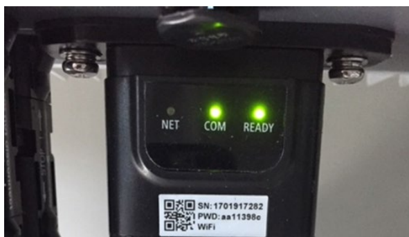
Figure 68 – État initial des LED
