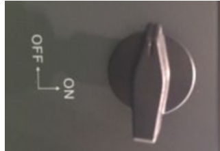
Figura 69 - Interruttore di disconnessione fotovoltaico
