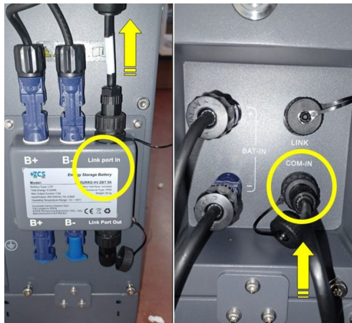
Рис. 117 - Комунікаційні з'єднання: BDU та перший акумуляторний модуль
