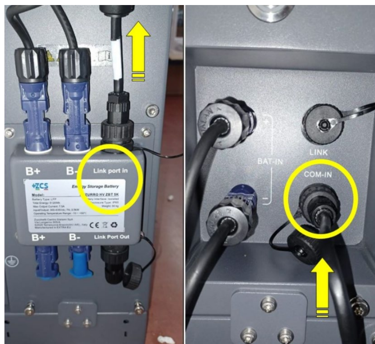
Рис. 133 - Комунікаційні з'єднання: BDU та перший акумуляторний модуль
